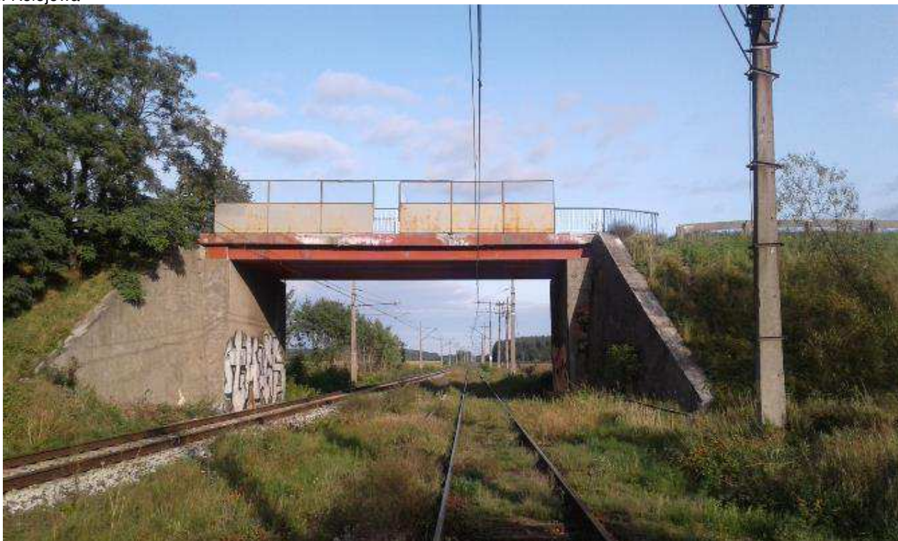
Fot.2. Widok z boku na wiadukt patrząc od stacji Minkowice Oławskie
