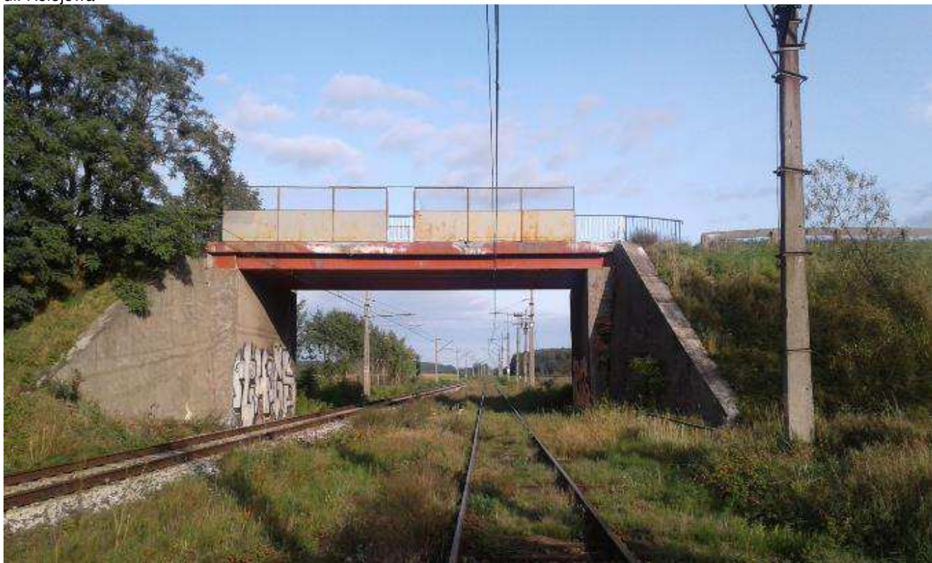
Rys. 1. Przedmiotowy wiadukt drogowy w km 0,850 w miejscowości Minkowice Oławskie (droga powiatowa 1548D)
