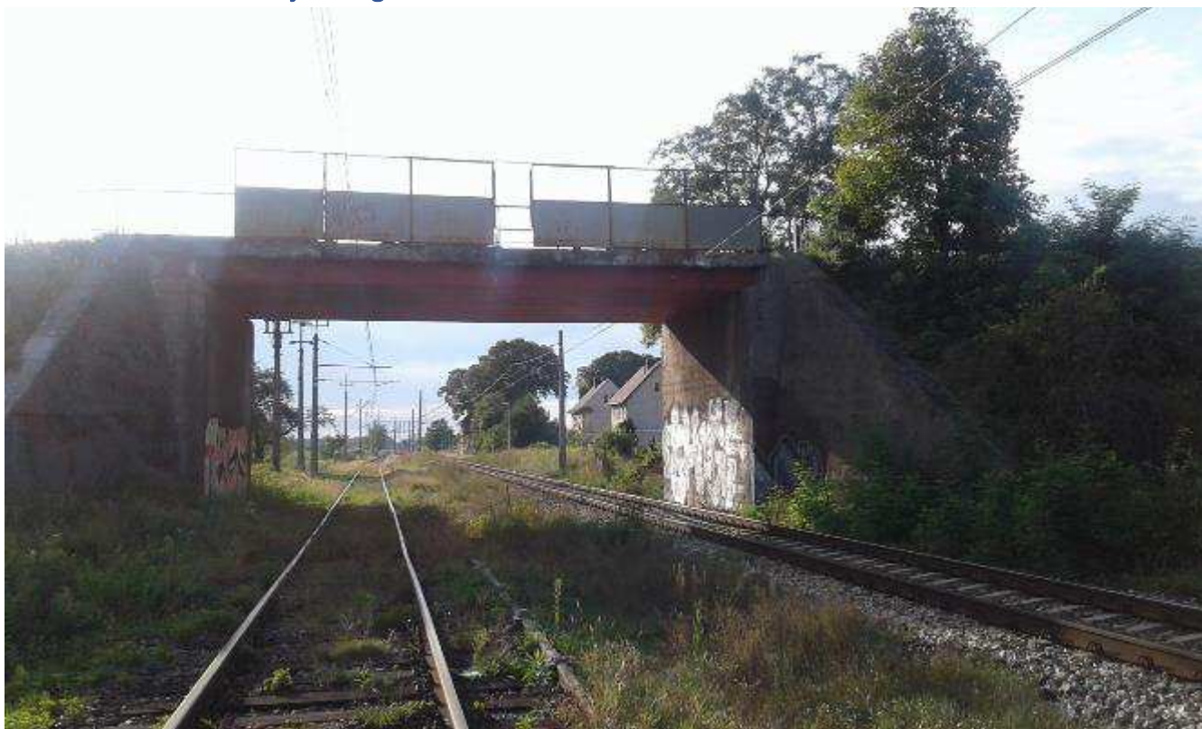
Fot.1. Widok z boku na wiadukt patrząc w stronę stacji Minkowice Oławskie
