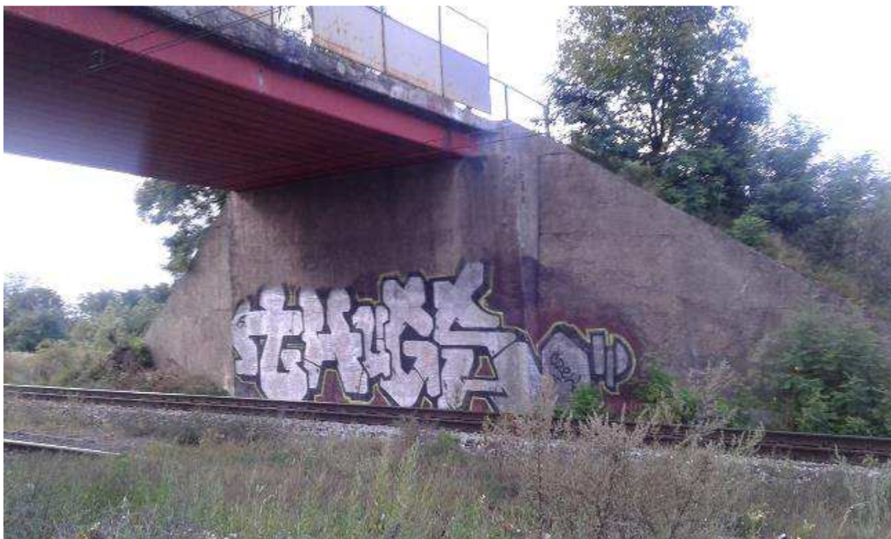
Fot. 5. Widok na przyczółek od strony Minkowic Oławskich. Widoczne graffiti
